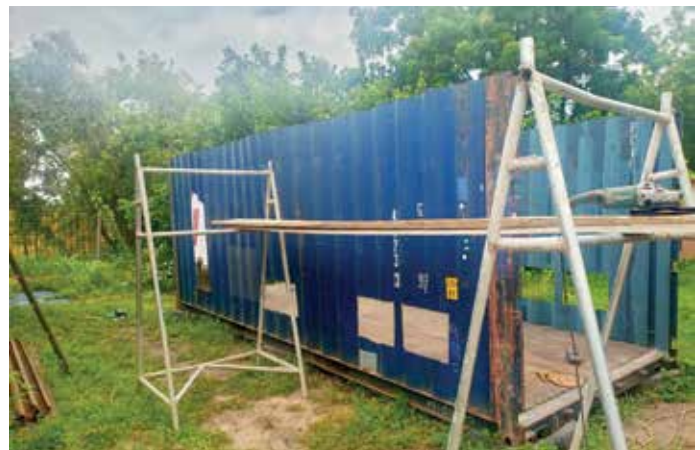
Caisse en construction pour la translocation des éléphants
