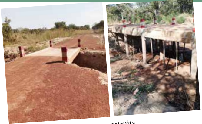
Nouveaux ponts construits
