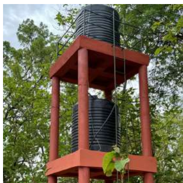
Châteaux d'eau à Tanguiéta
